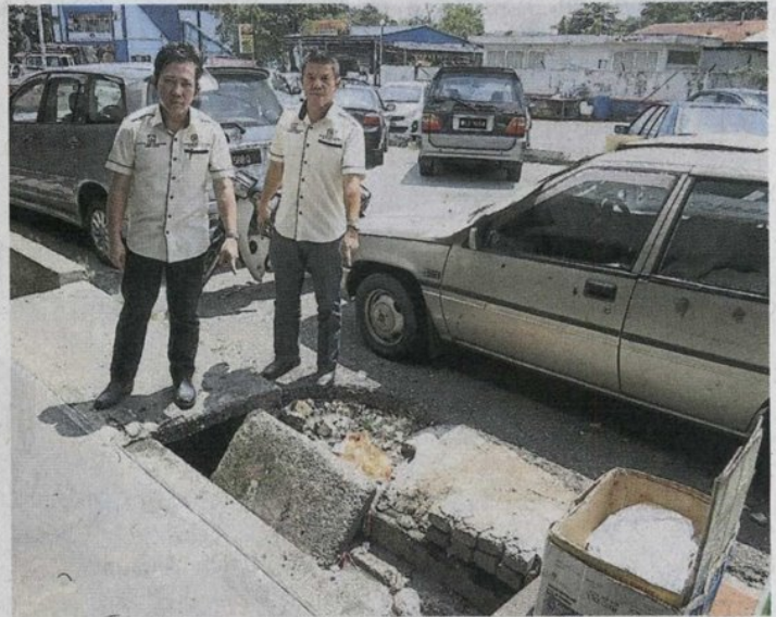
溝渠旁馬路坍塌，導致洋灰溝蓋掉入溝渠，影響排水。
